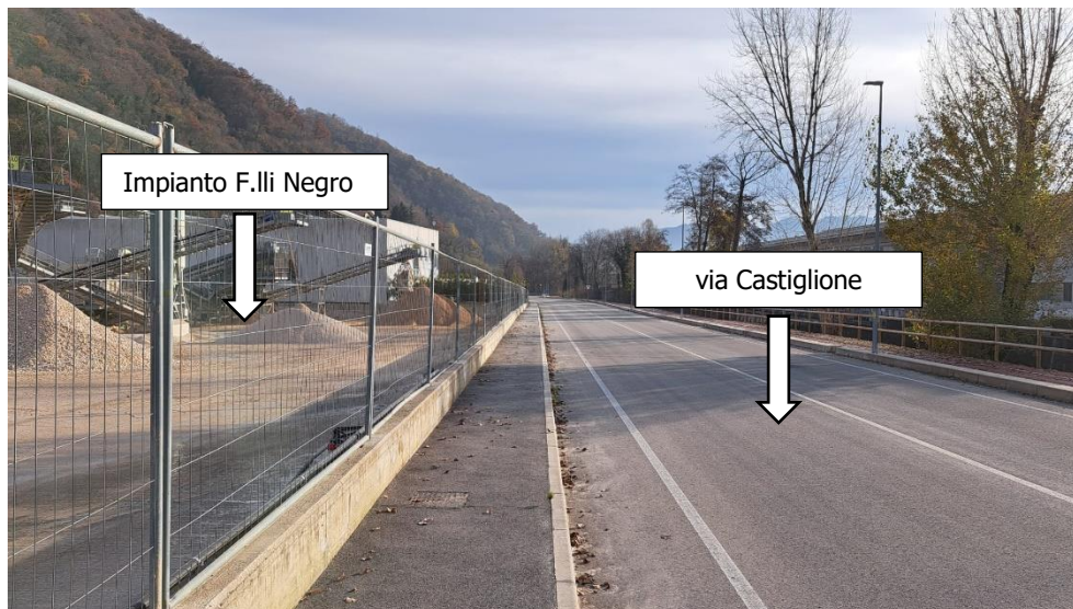
FIGURA 6. RIPRESA FOTOGRAFICA DI VIA CASTIGLIONE. LA REALIZZAZIONE DELLA CARREGGIATA STRADALE E DEL MARCIAPIEDE HA COMPORTATO L'ELIMINAZIONE DEL FILARE ALBERATO POSTO LUNGO IL LATO OVVERO DELL'IMPIANTO AZIENDALE DI TRATTAMENTO.
